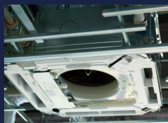
エアコン設置工事
